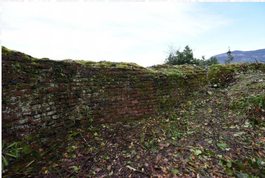
Detalj zidanja unutrašnjeg zida / The detail of building the inner wall
